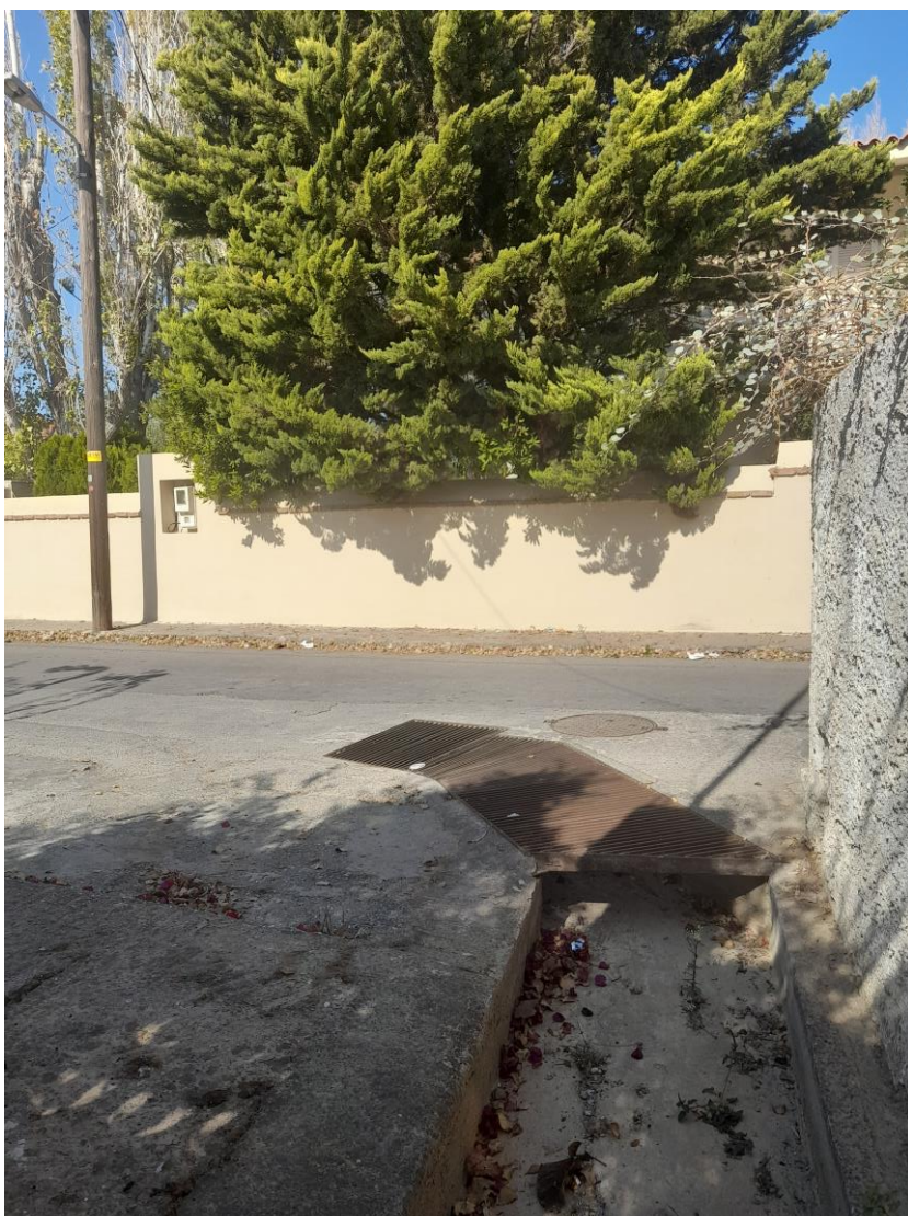
Φωτογραφία 2: Άποψη υφιστάμενου φρεατίου εισόδου ανοικτού αγωγού – καναλιού συγκέντρωσης και απορροής ομβρίων ανάντη περιοχής Μεσαίου Καρλοβάσου στην συμβολή του με την οδό Γ. Ρίτσου στον υφιστάμενο αγωγό Φ300.
