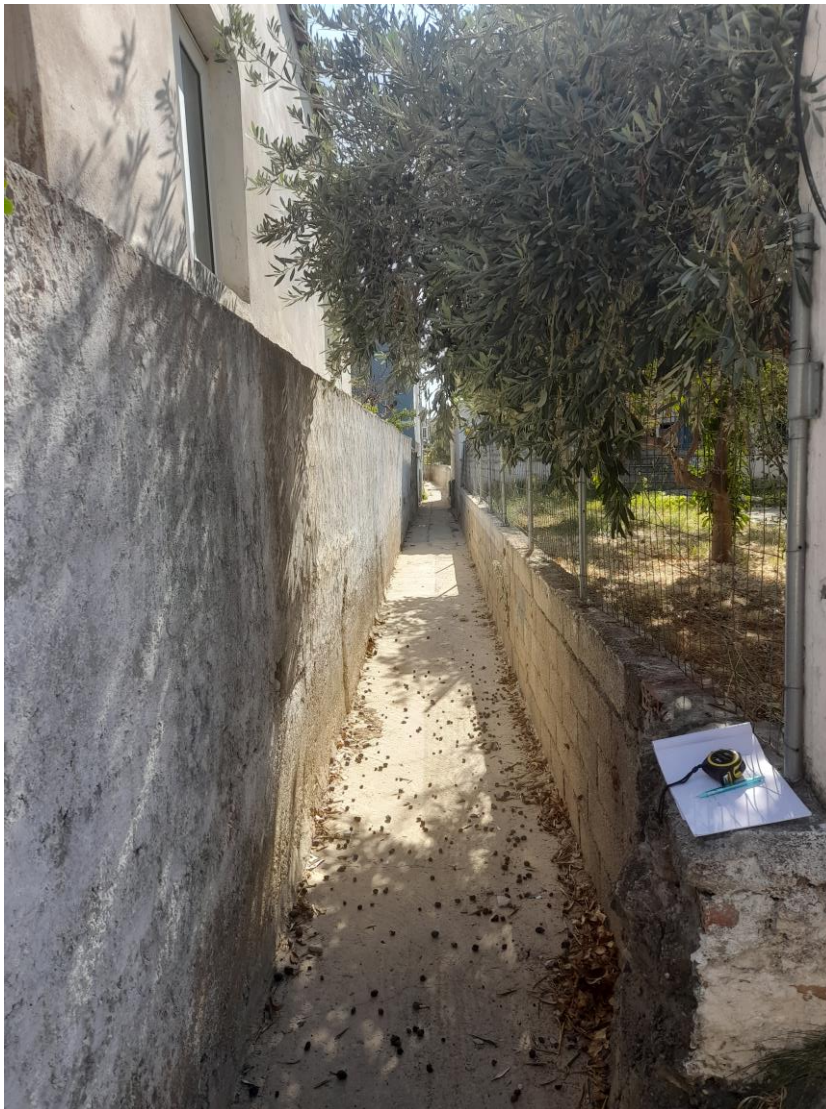
Φωτογραφία 1: Άποψη ανοικτού αγωγού – καναλιού συγκέντρωσης και απορροής ομβρίων ανάντη περιοχής Μεσαίου Καρλοβάσου από τα ανάντη.
