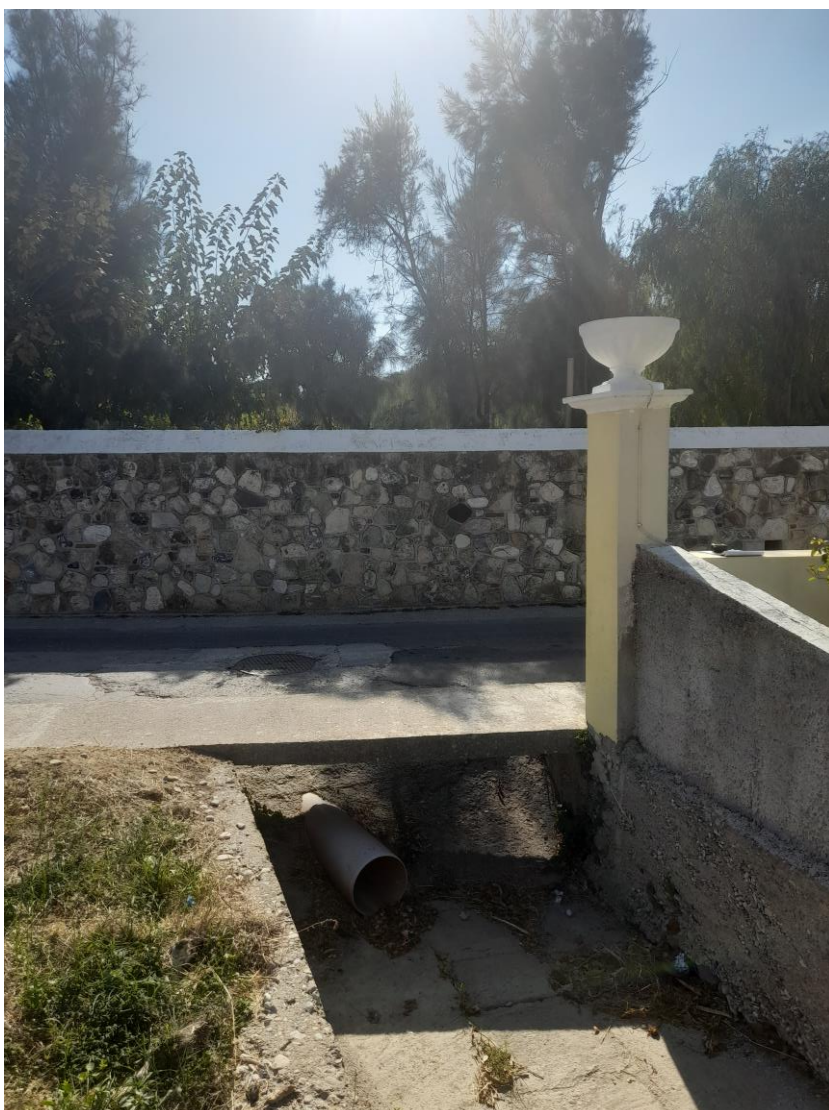
Φωτογραφία 5: Άποψη από τα κατάντη υφιστάμενου σωληνωτού αγωγού αποχέτευσης ομβρίων από PVC διαμέτρου \Phi 300 , στο σημείο εκροής σε κάθετο με την οδό Γ. Ρίτσου ανοικτό επενδεδυμένο με σκυρόδεμα κανάλι απορροής στην θάλασσα.
