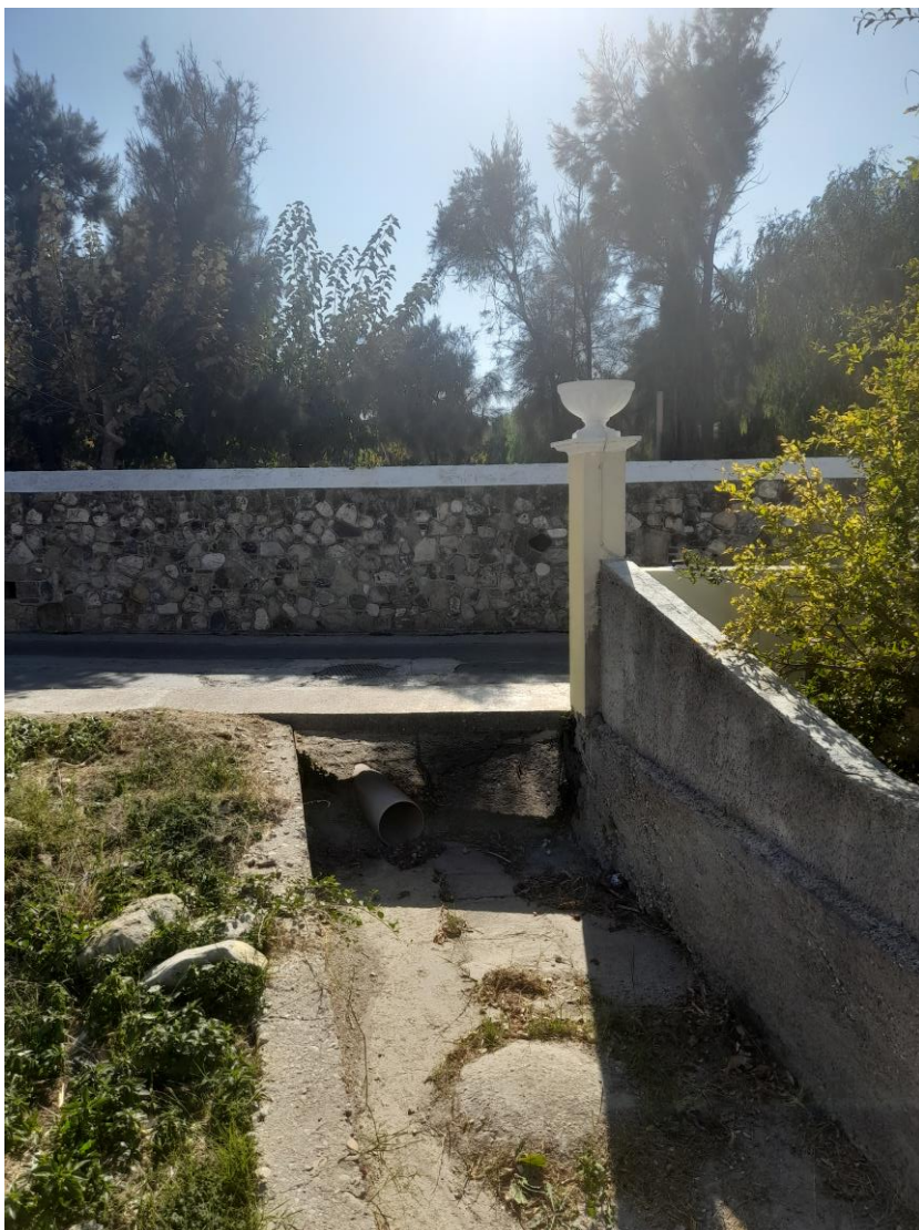
Φωτογραφία 6: Άποψη από τα κατάντη υφιστάμενου σωληνωτού αγωγού αποχέτευσης ομβρίων από PVC διαμέτρου Φ300, στο σημείο εκροής σε κάθετο με την οδό Γ. Ρίτσου ανοικτό επενδεδυμένο με σκυρόδεμα κανάλι απορροής ομβρίων στην θάλασσα.
