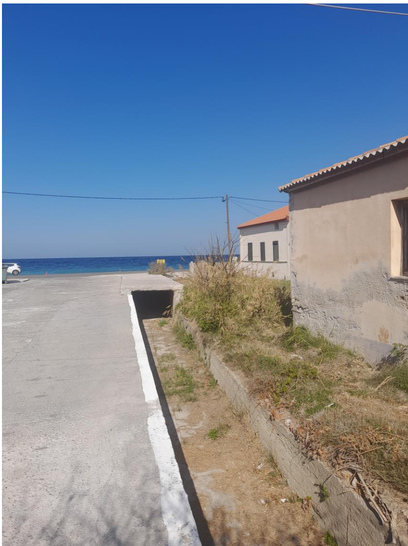
Φωτογραφία 8: Άποψη από τα ανάντη προς τα κατόντη ανοικτού επενδεδυμένου με σκυρόδεμα καναλιού απορροής ομβρίων στην θάλασσα μέσω πλακοσκεπούς οχετού κάτωθεν της παραλιακής οδού Καρλοβάσου.
