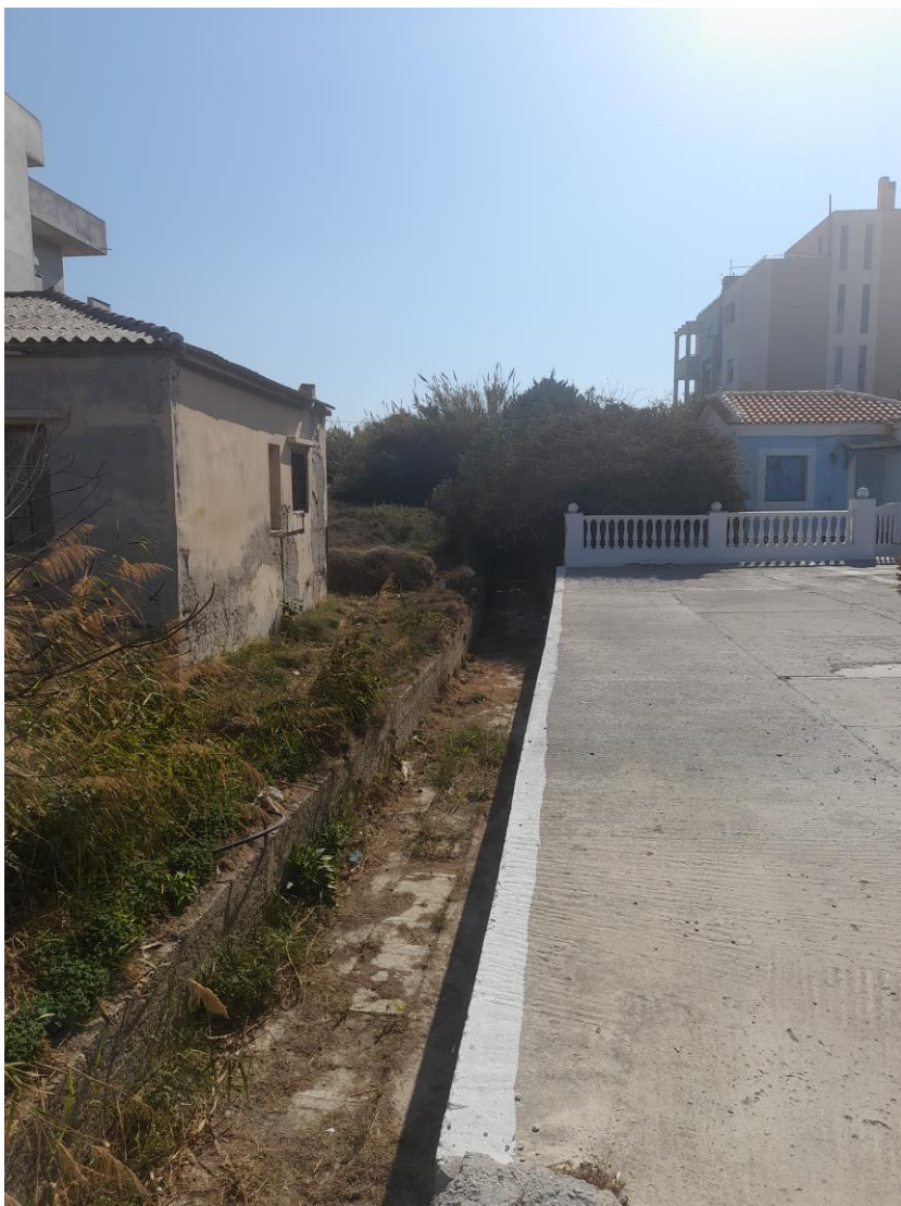
Φωτογραφία 10: Άποψη από τα κατάντη προς τα ανάντη ανοικτού επενδεδυμένου με σκυρόδεμα καναλιού απορροής ομβρίων στην θάλασσα.
