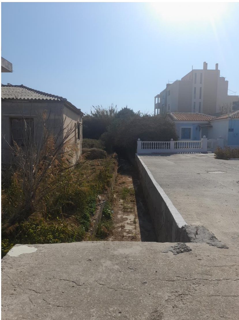
Φωτογραφία 9: Άποψη από τα κατάντη προς τα ανάντη ανοικτού επενδεδυμένου με σκυρόδεμα καναλιού απορροής ομβρίων στην θάλασσα μέσω πλακοσκεπούς οχέτου κάτωθεν της παραλιακής οδού Καρλοβάσου.
