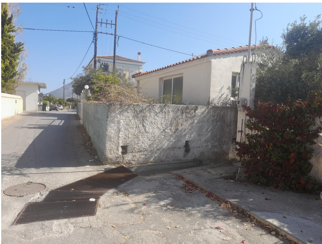
Φωτογραφία 4: Άποψη από τα κατάντη υφιστάμενου φρεατίου εισόδου του ανοικτού αγωγού – καναλιού συγκέντρωσης και απορροής ομβρίων ανάντη περιοχής Μεσαίου Καρλοβάσου στην συμβολή του με την οδό Γ. Ρίτσου στον υφιστάμενο αγωγό Φ300.
