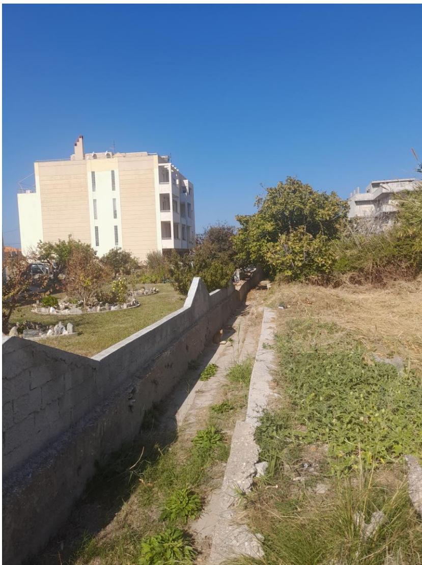
Φωτογραφία 7: Άποψη από τα ανάντη προς τα κατόντη ανοικτού επενδεδυμένου με σκυρόδεμα καναλιού απορροής ομβρίων στην θάλασσα.
